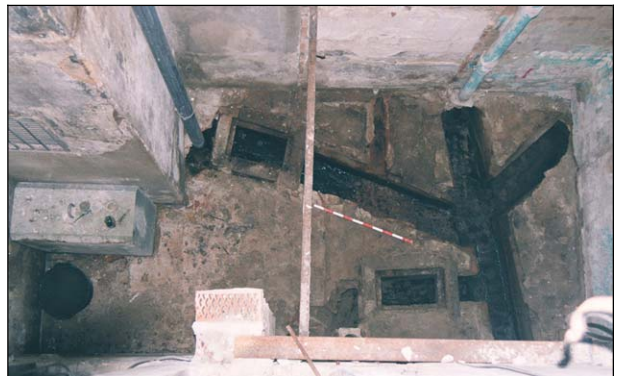
FOTO 64. Vista general del mateix celobert de la fotografia anterior, però sense les tapes de les clavegueres UE 634, UE 637, UE 640, UE 643 i UE 648
