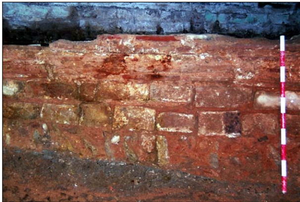
FOTO 65. Vista en detall dels tancaments superposats UE 794 i UE 776, col·locats sobre la riostra UE 798
