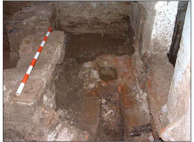
FOTO 42. Vista de l'estructura de contenció UE 5058
