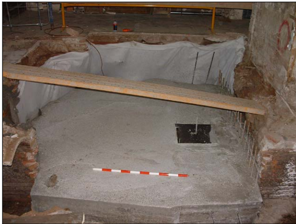
FOTO 5. Vista final de la sala 1 una vegada desmuntades les estructures i bastida la sabata del pilar amb formigó
