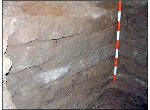
FOTO 22. Vista en detall de l'alçat del dipòsit UE 2093/2094
