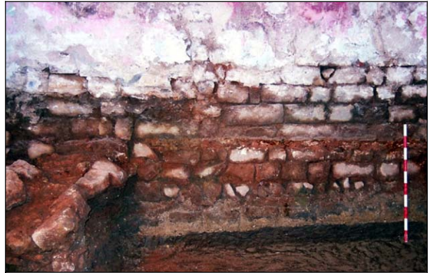
FOTO 62. Vista del mur UE 729
