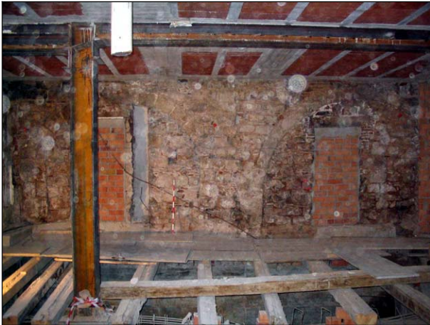
FOTO 25. Vista general de les arcades UE 2120 i 2127, així com dels tancaments UE 2122, UE2124, UE 2128, UE 2135 i UE 2123
