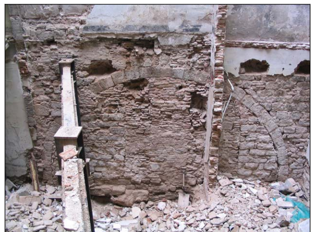
FOTO 80. Vista en alçat de l'arcada UE 895/7042 i dels tancaments UE 863, UE 899 i UE 8036
